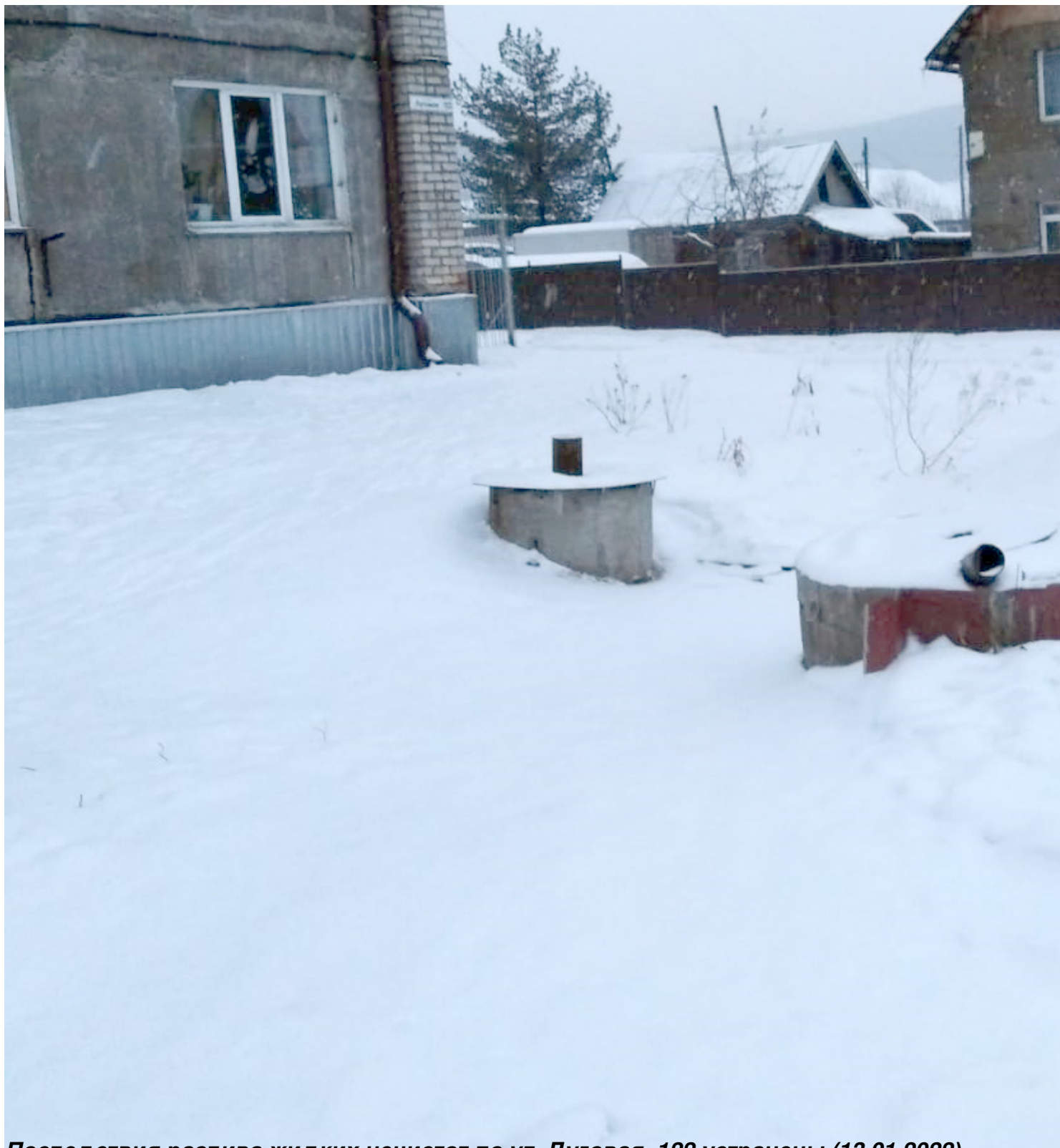
Последствия разлива жидких нечистот по ул. Луговая, 122 устранены (13.01.2022)
